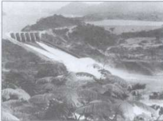
18.4. ábra. A ghanai Volta-folyóra épített vízerőmű (Fotó: a FAO jóvoltából) A vízgyűjtő erdeit meg kell őrizni a duzzasztómű hatékony működésének érdekében.
