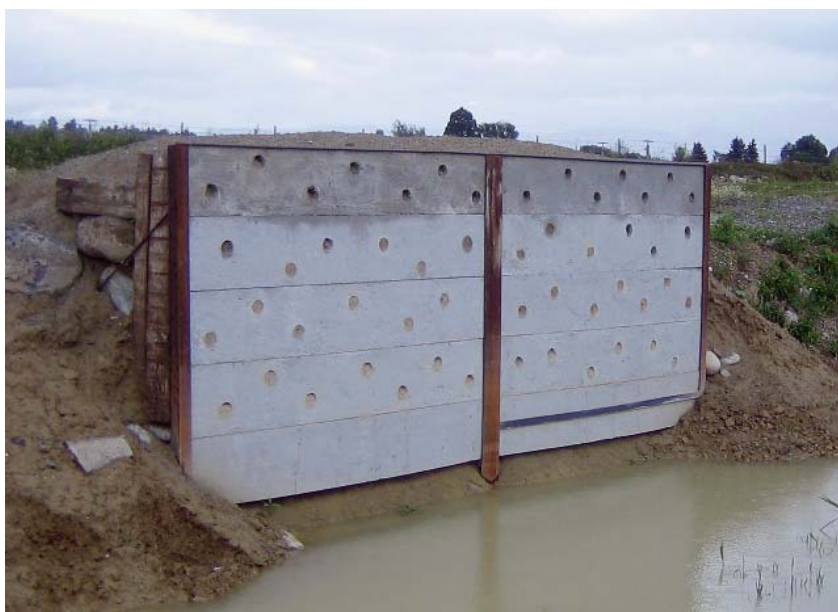
Paroi en pièces de béton assemblées à Hindelbank CH.
