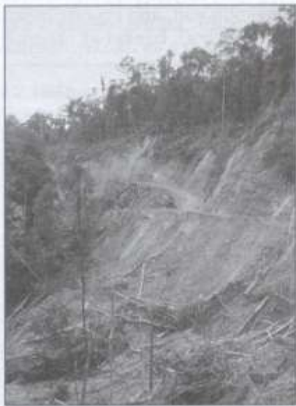
4.7. ábra. A meredek hegyoldalakon végrehajtott faki-termelés és útépités intenzív talajerózióhoz és földcsuszamláshoz vezethet, ami jelentősen csökkenti az erdők gazdasági értékét (Fotó: Richard Primack)
