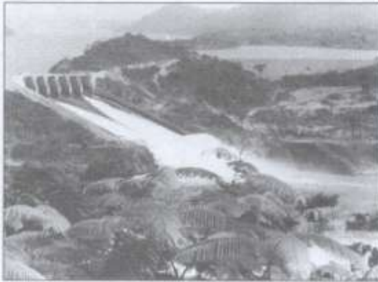
18.4. ábra. A ghanai Volta-folyóra épített vízerőmű (Fotó: a FAO jóvoltából) A vízgyűjtő erdeit meg kell őrizni a duzzasztómű hatékony működésének érdekében.
