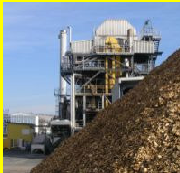
Pellet tüzelésű kazán és fluidágyas bioerőmű
