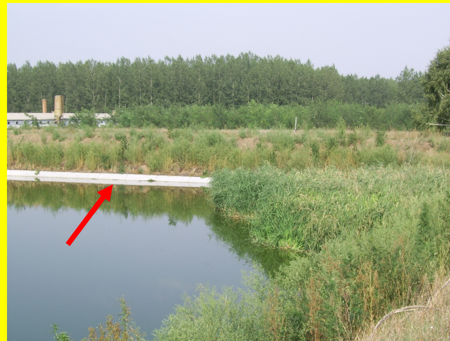
Hígtrágya kibetonozott medencében
